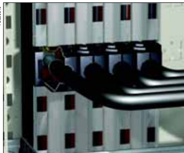
Защёлкивающиеся крышки для изоляции наконечников комплекта для подсоединения
