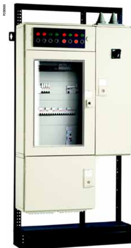
Монтаж на сборной раме
